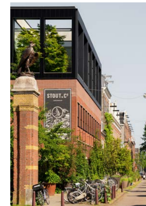
BOVEN DELVA EN ZIJN PARTNER TRANSFORMEERDEN DE BROUWERIJ TOT EEN MULTIFUNCTIONEEL GEBOUW, MET OP HET DAK HUN LOFT.
