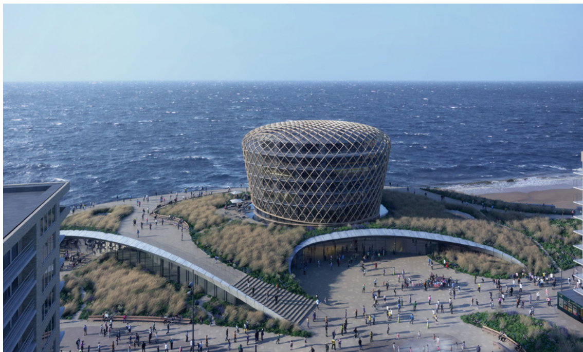
SILT Duincasino - Middelkerke | DELVA
