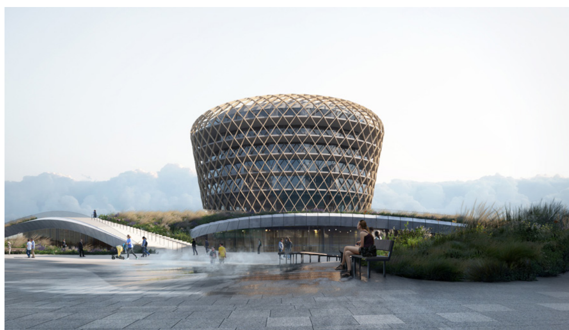
SILT Duincasino - Middelkerke | DELVA
